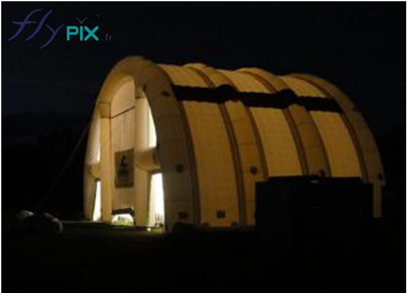
Vue extérieure pendant la nuit d'un hangar gonflable de grande taille.
